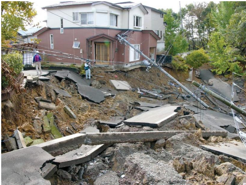
Figure 27: : Photographie illustrant les dommages subis par une habitation construite sur un remblai artificiel à la suite d'un glissement de terrain induit par le séisme de la préfecture de Niigata (Japon) en 2004. (© Professeur Kamai, Université de Kyoto, Japon)
