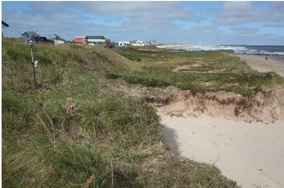
Figure 52: Côte à terrasse de plage affectée par l'érosion côtière
