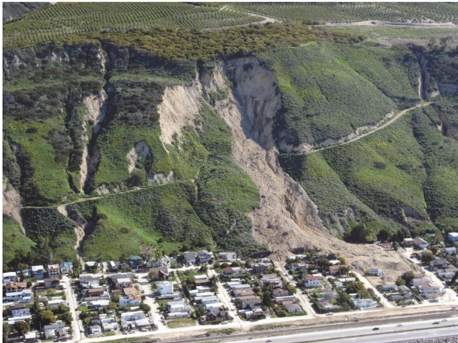
Figure 13: Ce glissement de terrain s'est produit à La Conchita, en Californie (États-Unis), en 2005. Il a causé la mort de dix personnes. (Photographie : Mark Reid, U.S. Geological Survey.)
