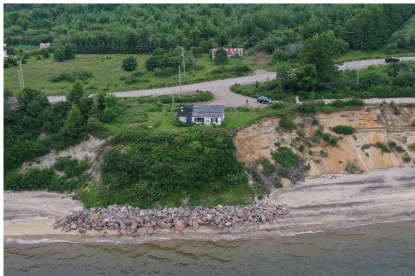
Figure 58: Effet de bout entraîné par des travaux d'enrochement. Source : MSP, 2021
