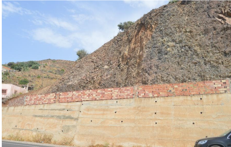
Figure 17: Construction de murs de soutènement dans les secteurs de la rocade méditerranéenne les plus exposés aux chutes de blocs rocheux (M. TAHER 2026)
